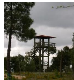
Fig. 5 – Torre de Observação
